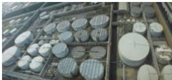
► 廢水處理場 (改善後)
